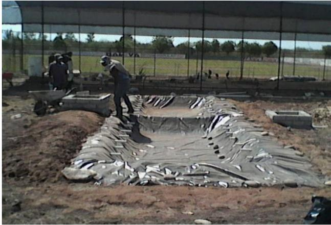
**Figura 1.** Nivelación y construcción del humedal artificial.
