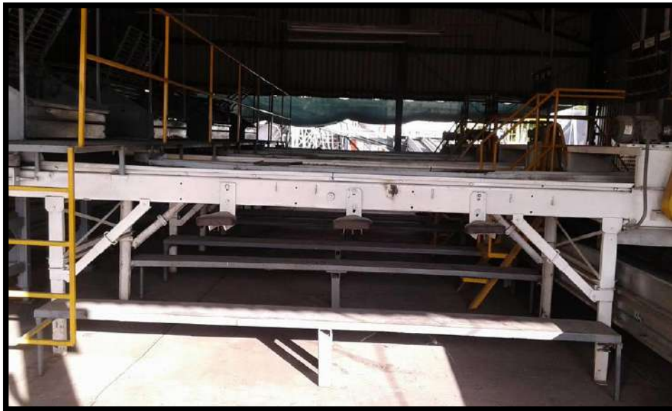
Figura 2. Área de deshojado.
