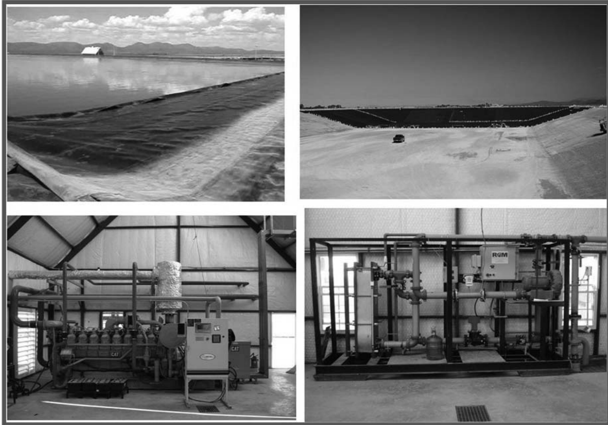
Figura 5. Imágenes de la construcción y puesta en marcha del Biodigestor más grande de América latina con un área de 2 ha. Para la generación de más de 5 millones de Kw por año.
