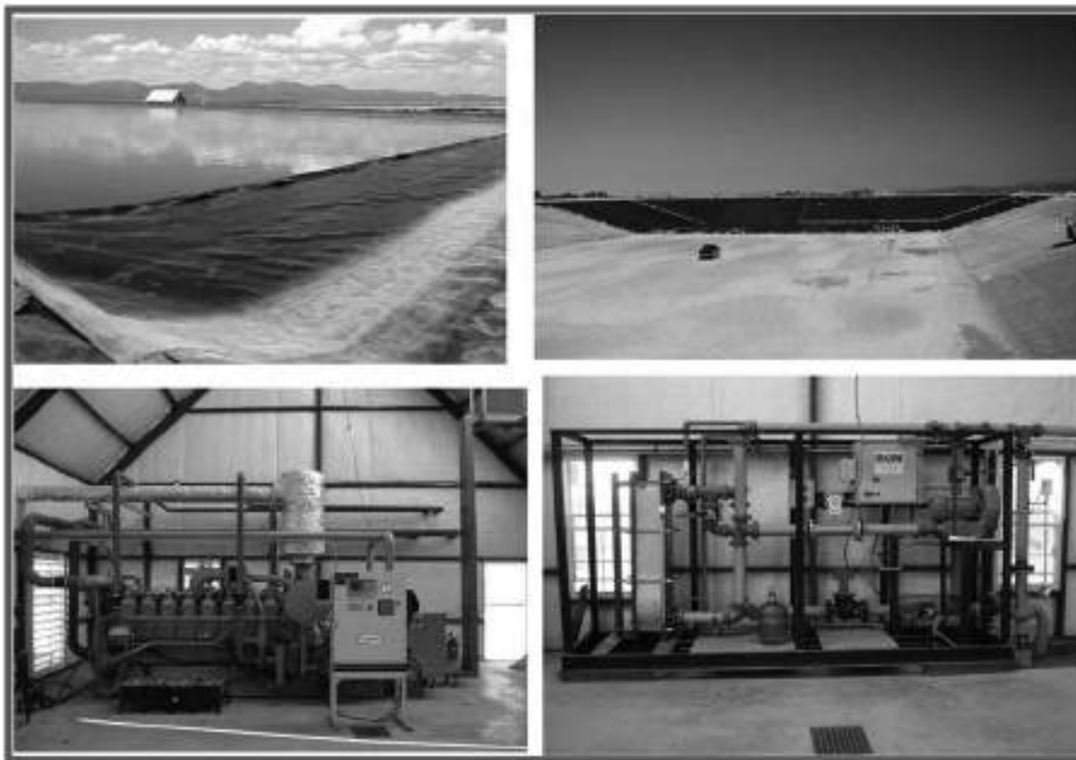
Figura 5. Imágenes de la construcción y puesta en marcha del Biodigestor más grande de América latina con un área de 2 ha. Para la generación de más de 5 millones de Kwas por año.
