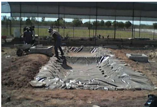
Figura 1. Nivelación y construcción del humedal artificial.
