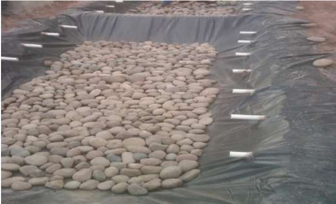
Figura 2. Dimensión y Colocación de grava papa \frac{3}{4} .
