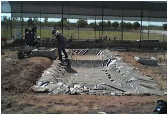
Figura 1. Nivelación y construcción del humedal artificial.
